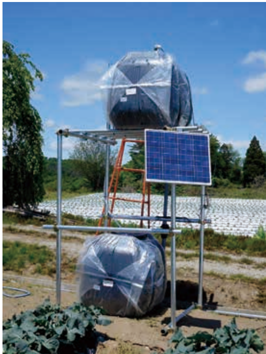
写真：自動かん水システム設置
