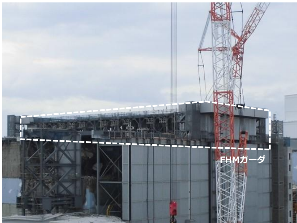
FHMガーダ建方状況 (撮影日2017年6月14日)
