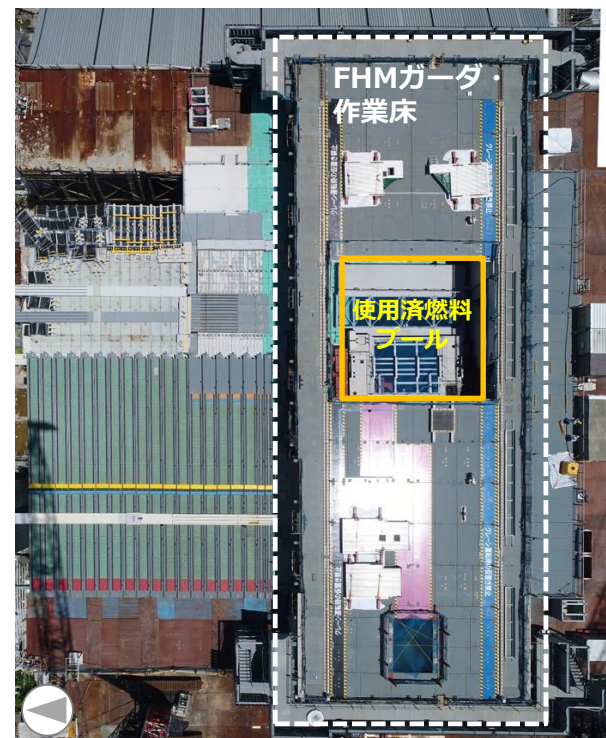
FHMガーダ建方状況 (撮影日2017年6月9日)
