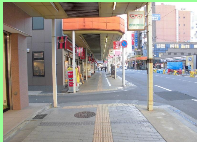
②南2ブロック工事着手前(平成29年2月28日撮影)
