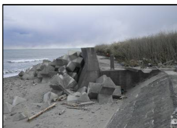
震災前の海岸堤防
