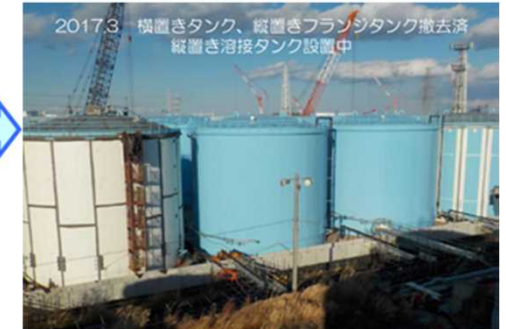
<5-1 横置き・フランジタンクリプレース状況 (H2タンクエリアの例) >
