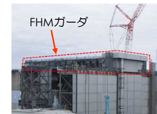
<5-3. FHMガーダ設置状況>
