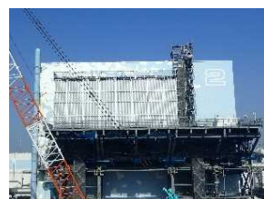
<4-2. 構台・前室設置状況>
