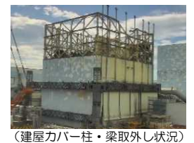
(建屋カバー柱・梁取外し状況)
