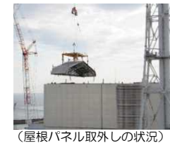
⑦ 1号機原子炉建屋カバー解体の状況
