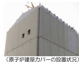
(原子炉建屋カバーの設置状況)
