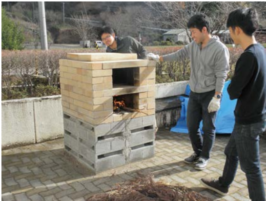
写真 ピザ釜試運転
