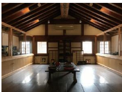
既存照明／垂木、棟木（構造体）
