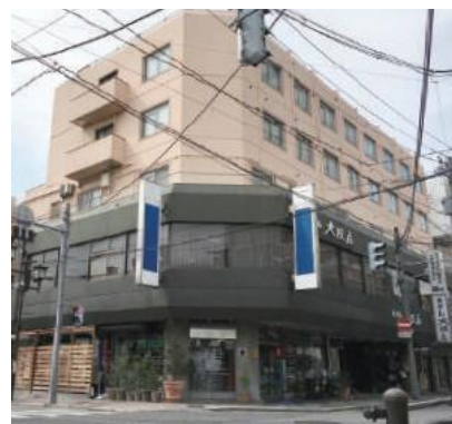
既存外部看板
