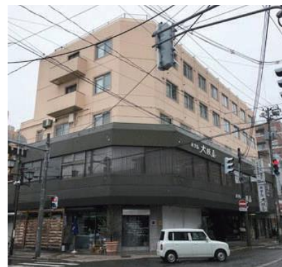
外部看板撤去
