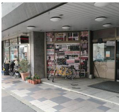
テナント部分外部サッシ／エントランス
