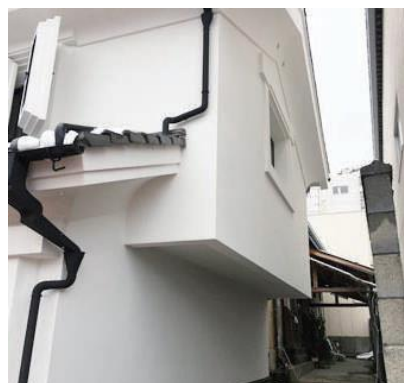
外壁漆喰修復箇所／建物側面
