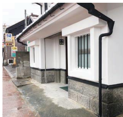
外壁漆喰修復箇所／窓まわり
