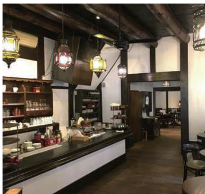
新規カウンター、新規壁、カーテン撤去
