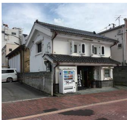
看板設置箇所／建物全景
