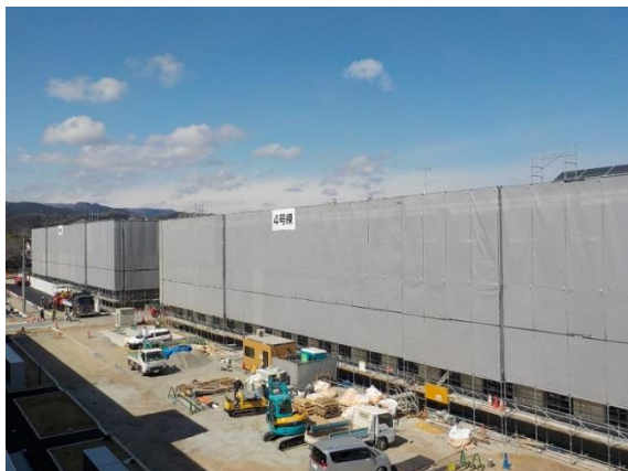
牛越団地整備状況（造成工事完了の様子）
