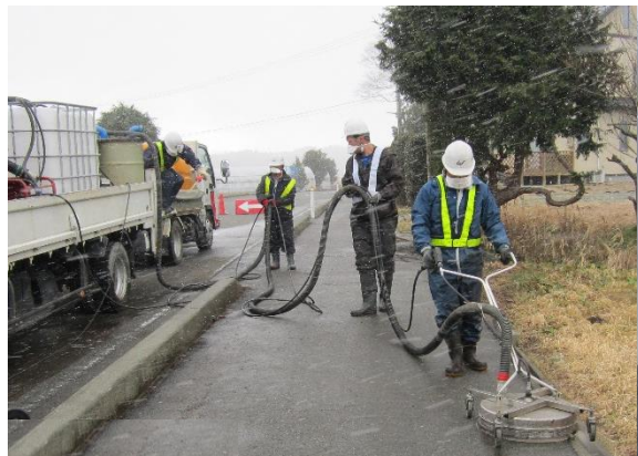
除染作業状況（大甕磐城太田停車場線）
