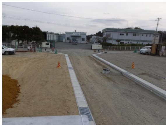
下北迫団地整備状況（造成工事完了の様子）
