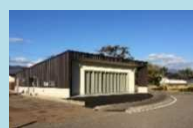
猪苗代水環境センター (猪苗代町)
