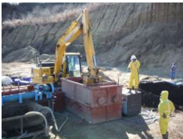
処理前土壌槽での混合作業
