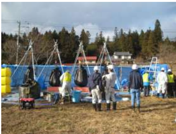
ゼオコン及びフレコンを吊した状態
