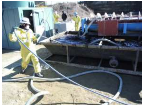
受槽での攪拌作業
