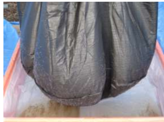
浸出水がしみ出ている様子
