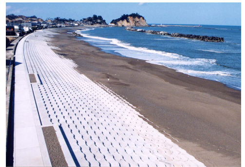
写真-17 久之浜海岸（いわき市）
