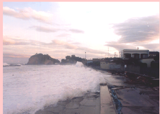
安全度の向上（越波状況） 久之浜海岸（いわき市）
