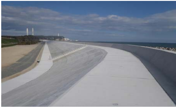
浅見川地区海岸（奥の煙突は広野火力発電所）
