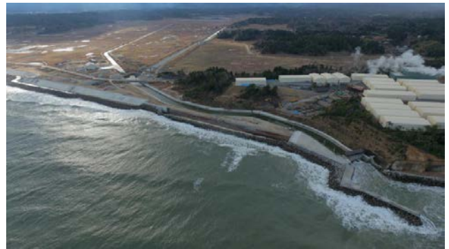
蛭沢地区海岸の施設全景（海口開門と内陸に伸びる潮遊び工） 手前海岸は復旧中の井田川地区海岸
