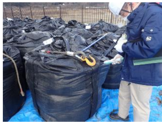
積み込み前のフレキシブルコンテナ確認
