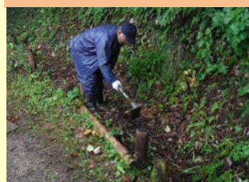
山側側溝のメンテナンス
