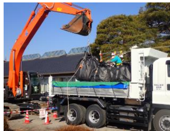
除染土壌等の積み込み確認
