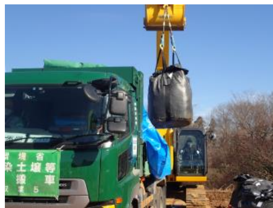
除染土壌等の積み込み確認
