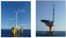
2MW風車「ふくしま未来」 洋上変電所「ふくしま絆」
