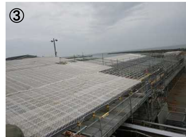
③ 放水口周辺
