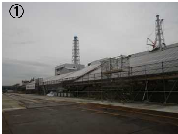
① サブドレン移送ポンプ建屋周辺
