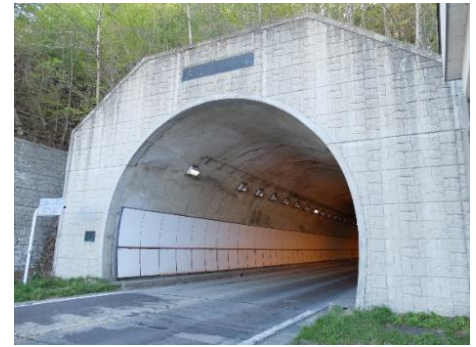
土湯トンネル(猪苗代坑口)
