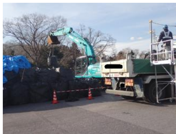
除染土壌等の積下ろし作業確認
