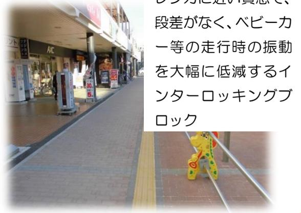
レンガに近い質感で、段差がなく、ベビーカー等の走行時の振動を大幅に低減するインターロッキングブロック
