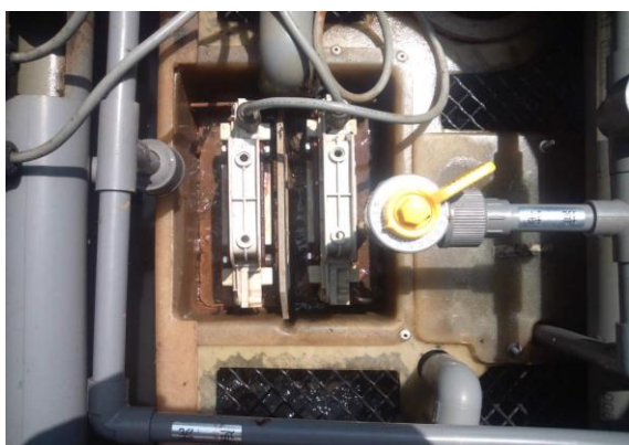
写真1 鉄電極板の設置状況
