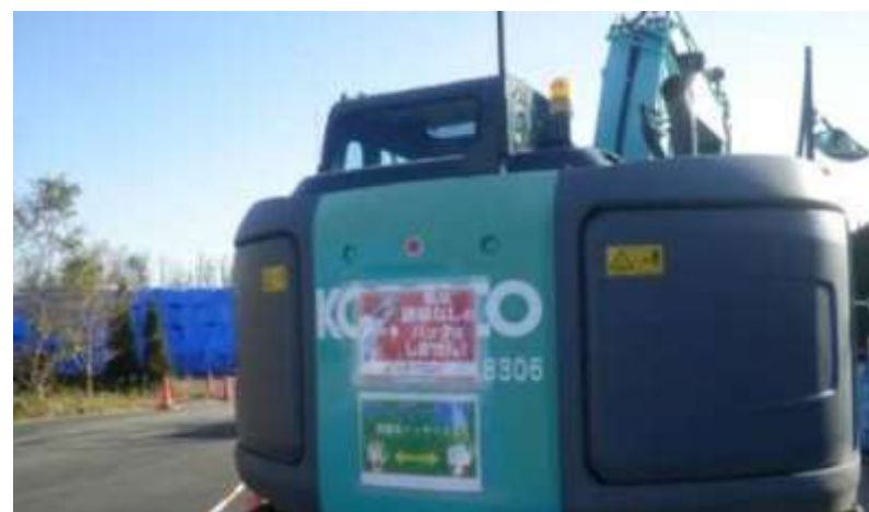
ステッカーによる作業員への周知
