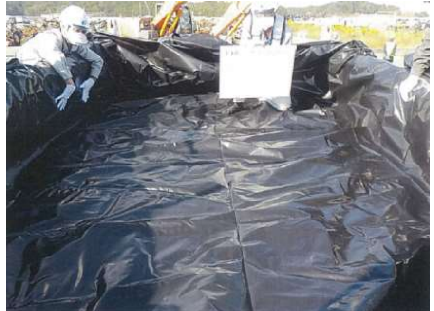
(水漏れ防止対策の一例)輸送車両荷台への遮水シートの設置
