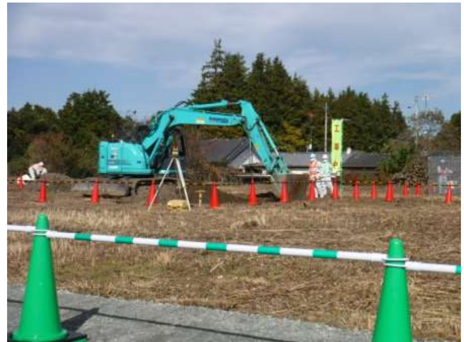
土壌貯蔵施設予定地における線量低減措置
