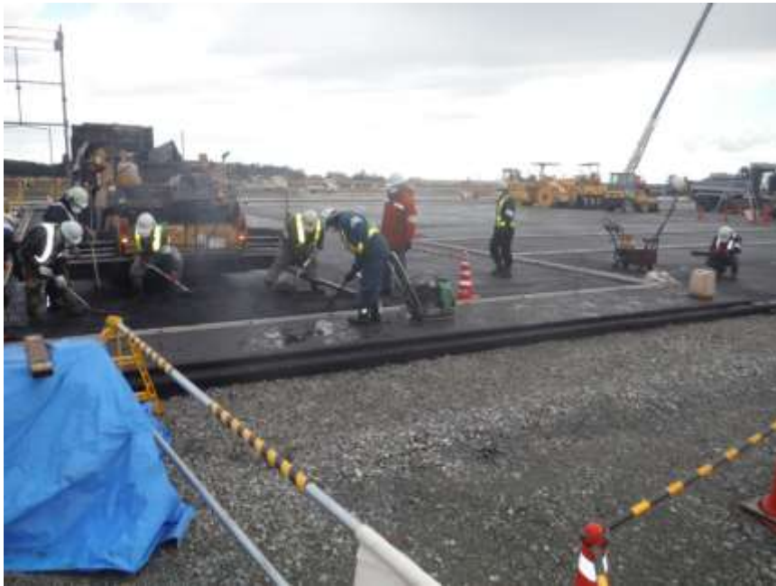
受入・分別施設予定地における舗装工
