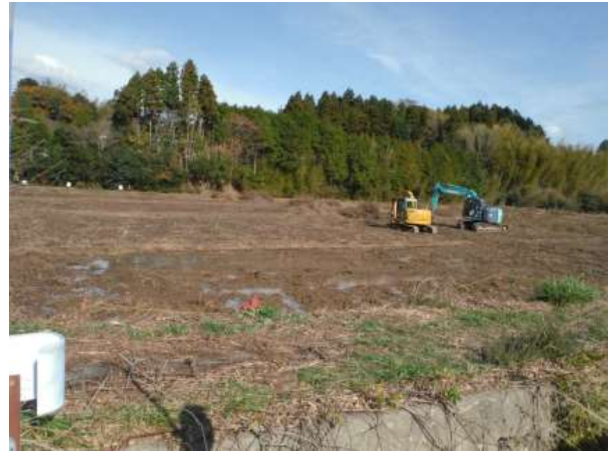
土壌貯蔵施設予定地における伐採・除草作業
