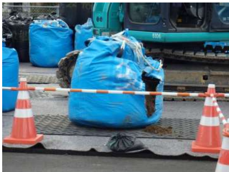
フレコンバッグ破損の状況
