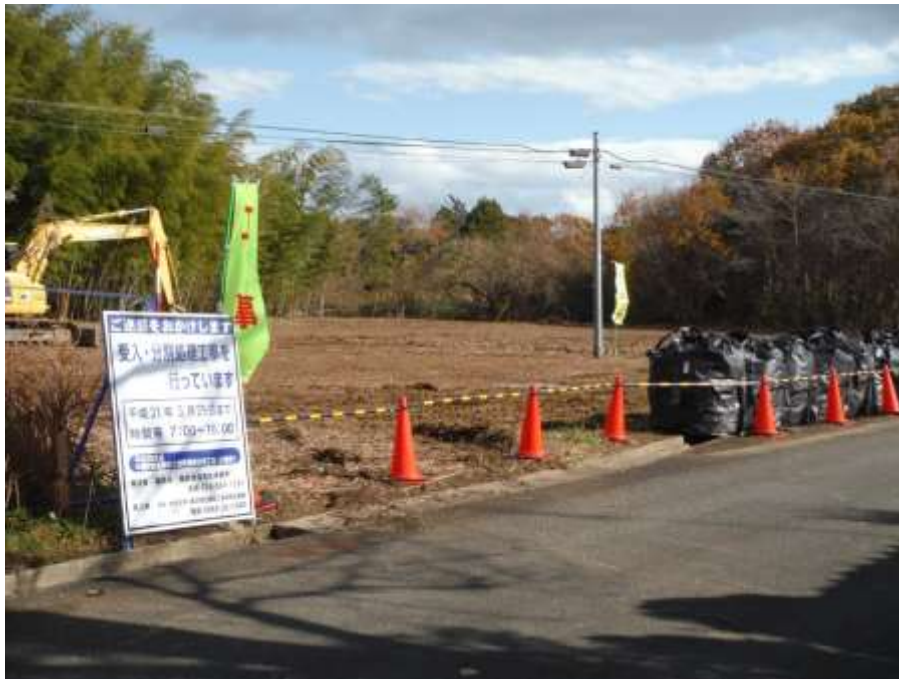
受入・分別施設予定地における伐採・造成工事
