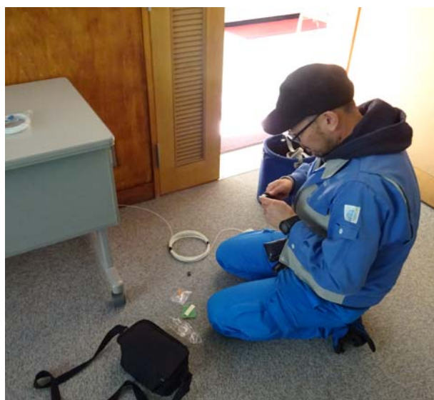
▲センター試験用の電話回線工事が行われた。(9日)
