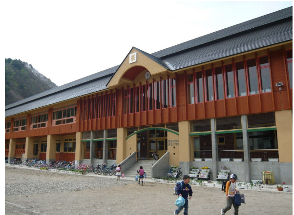
南会津町立館岩小学校(外装)
