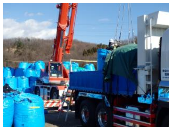
(本宮市) 除染土壌等の積み込み確認
