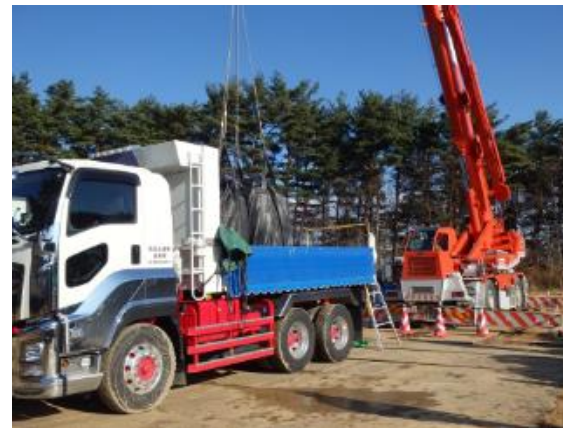
(大玉村) 除染土壌等の積み込み確認
