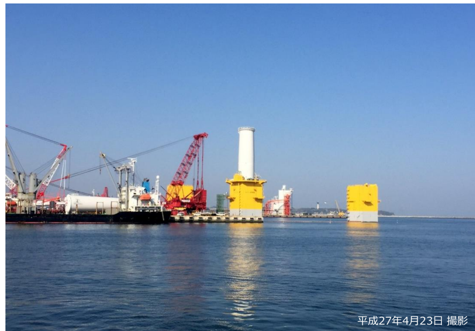
【藤原ふ頭での洋上風力発電設備の組み立て状況】
