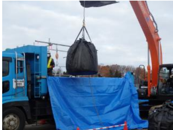
(三春町) 除染土壌等の積み込み作業確認
