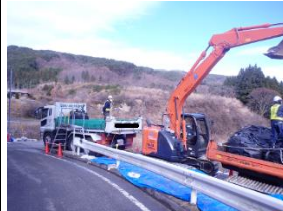
(田村市) 除染土壌等の積み込み作業確認
