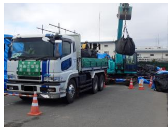
除染土壌等の積下ろし作業確認
