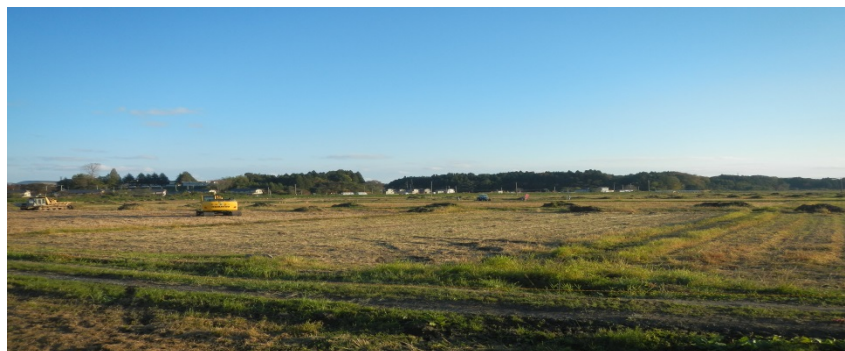
南相馬市小高区飯崎地区 工事着手
