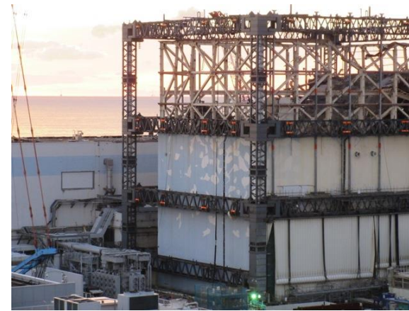
取り外し後の原子炉建屋
