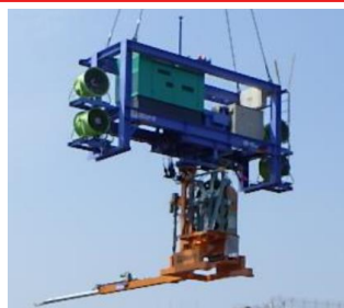
コア抜き調査
