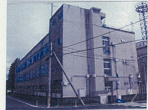
(5) 現況写真(北分庁舎解体前)
