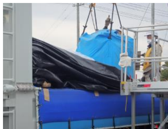
除染土壌等の積下ろし作業確認
