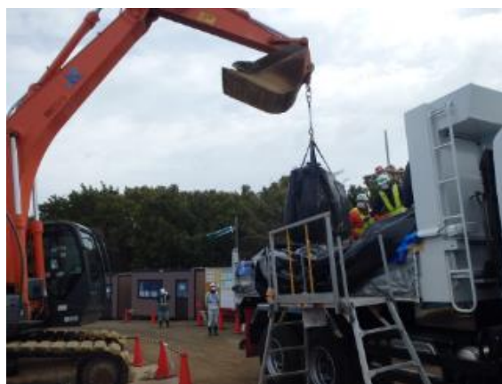
除染土壌等の積み作業確認
