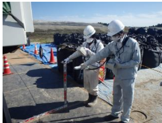
仮置場出発前の輸送車周辺の空間線量率測定 (相馬市)
