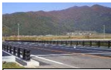
橋梁の長寿命化対策(施工後)
