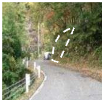
緊急的な現道対策 (カーブの見通し改善など)
