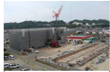
復興公営住宅(下神白団地) (H26.6現在)
