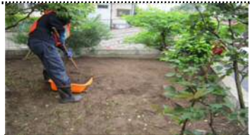
住宅除染作業
