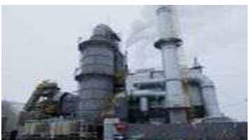
仮設焼却炉の設置
