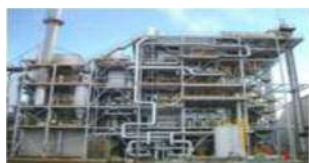
木質バイオマス発電施設
