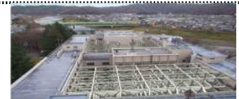
県庁舎改修工事
