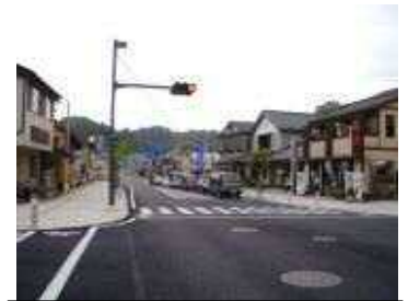
景観に配慮した道路整備（三春町）
