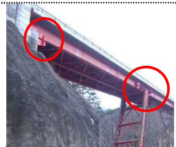
橋梁の耐震補強(施工後)
