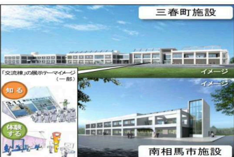
福島県環境創造センター
