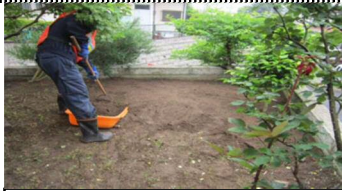
住宅除染作業
