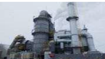
仮設焼却炉の設置
