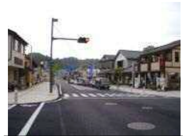
景観に配慮した道路整備（三春町）
