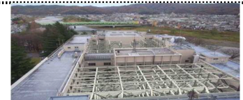
県庁舎改修工事
