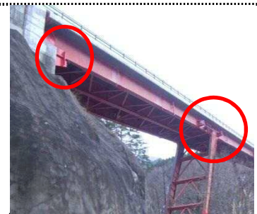
橋梁の耐震補強(施工後)
