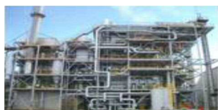
木質バイオマス発電施設
