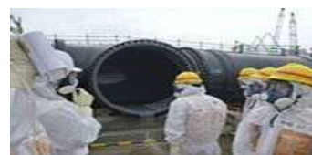
廃炉安全監視協議会による現地調査
