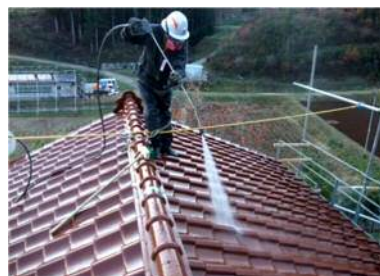
住宅の除染作業
