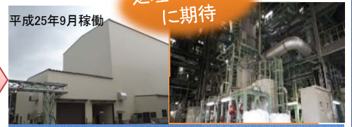
県中浄化センター内に焼却施設を導入
