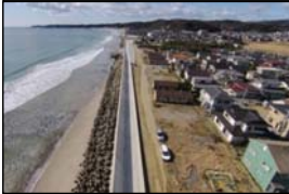
関田地区海岸堤防 (完成 H28.3)
