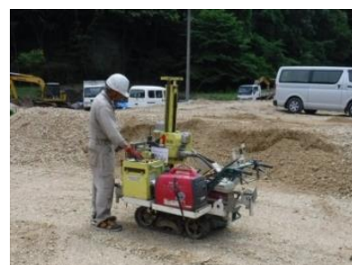
地盤調査作業
