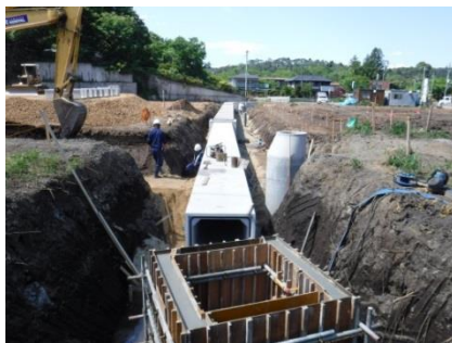
水路の布設、集水柵の据付工事
