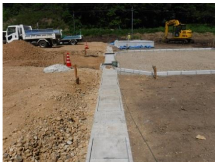
側溝の据付工事
