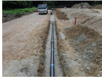
上水道布設工事
