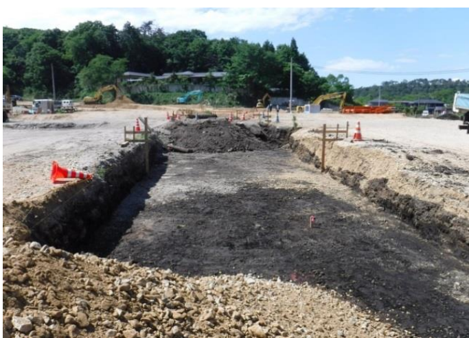
道路の掘削工事
