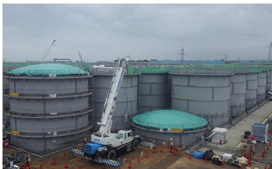
写真4：フランジタンク解体工事
