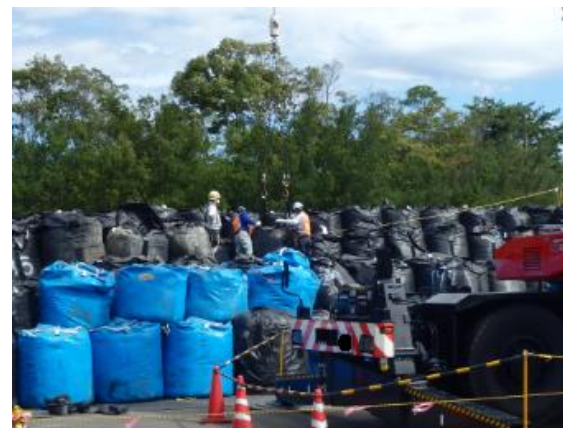
除去土壌等の積下ろし作業確認
