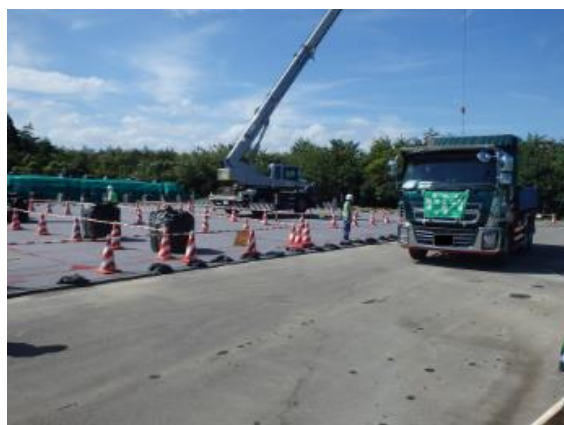
除去土壌等の積下ろし作業確認
