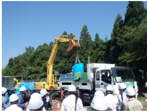
除去土壌等の積み込み作業
