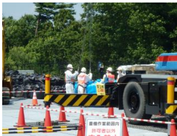
除去土壌等の積下ろし作業
