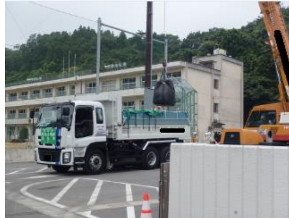
除去土壌等の積み込み作業
