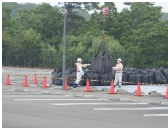
除去土壌等の積下ろし作業
