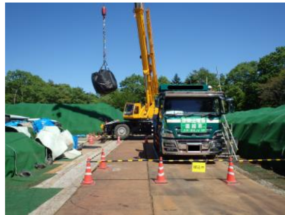
除去土壌等の積み込み作業
